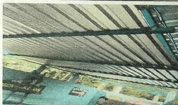
Foto 6: Sustitución de estructura de soporte de madera por costanera GLV 4X2 "16" en el tercer modulo
